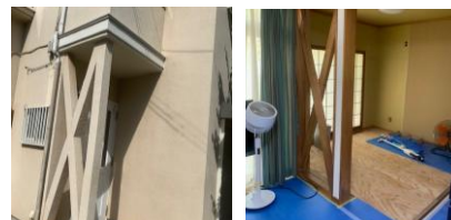
倒壊防止の現しのX形筋違45×100
