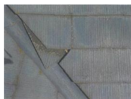
コロニアル屋根の割れ、軒先と雨樋の劣化状況
