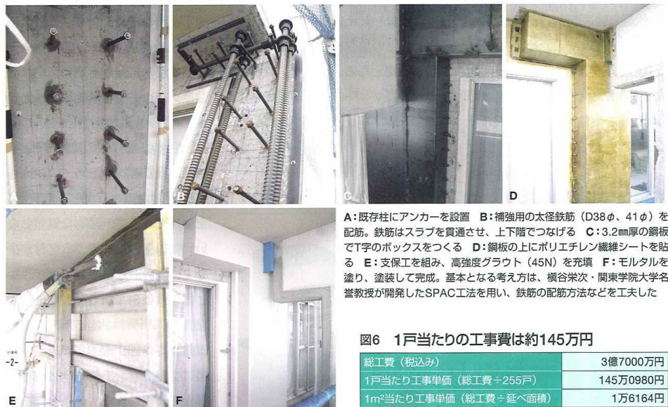
写真3 鋼板の型に高強度グラウトを充填
