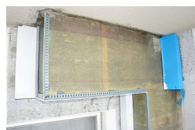
ボルトカバー取付
