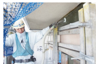
高強度グラウト（45N）打設
