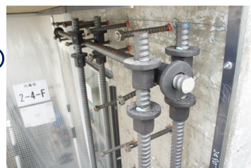
最上部はD38φ鉄筋を補強 端部のカブラーを設置
