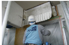
高強度繊維シート張付張り付け
