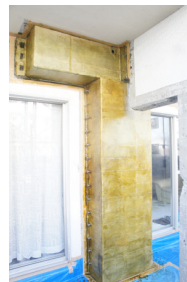
高強度繊維シートをアクリル樹脂で接着
