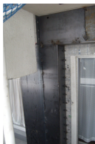
t3、2の鉄板を点付け溶接
