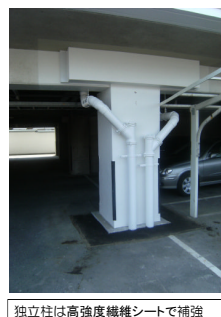
独立柱は高強度繊維シートで補強
