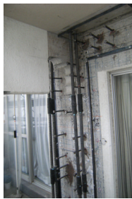
D38φの鉄筋を設
