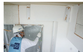
モルタル面塗装 端部シーリング
