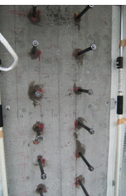
D19φ鉄筋をアンカー
