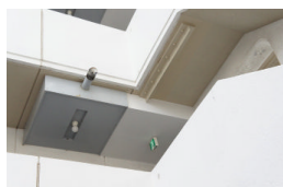
階段はスラブを鉄骨補強
